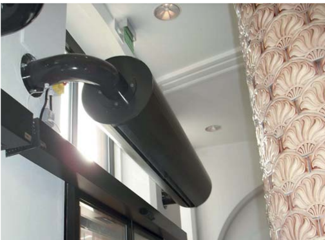
RUND Schwarze Beschichtung und Befestigung durch Arme / Black coating and fixation through arms
