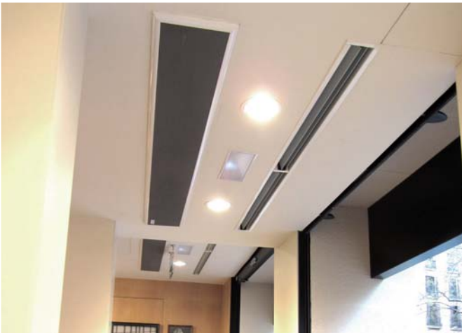
WINDBOX W Für einen nicht sichtbaren Zwischendeckeneinbau / Invisible installation with suspended ceiling kit
