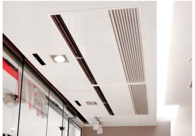
WINDBOX WR Für einen bündigen Zwischendeckeneinbau / Designed to be installed in a suspended ceiling
